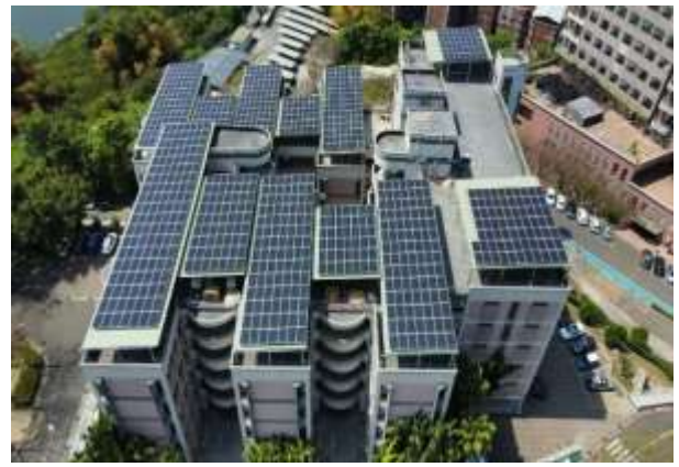
施工完成照片
