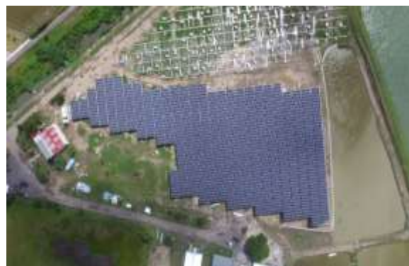
施工完成照片
