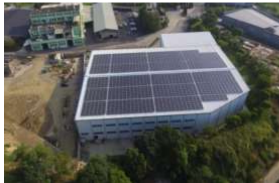
施工完成照片
